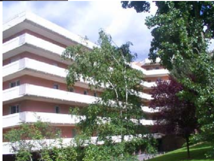
Résidence Grimpré bâtiment 2
