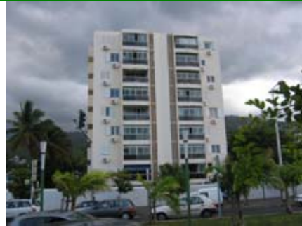
Résidence Olympe 1 36 logements PVC fermeture loggias et climatisation 315 000 €HT
