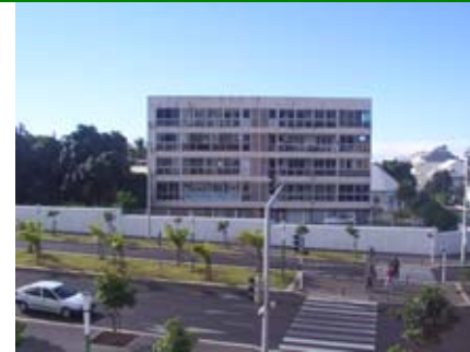
Résidence Olympe 2 16 logements PVC fermeture loggias et climatisation 92 000 €HT
