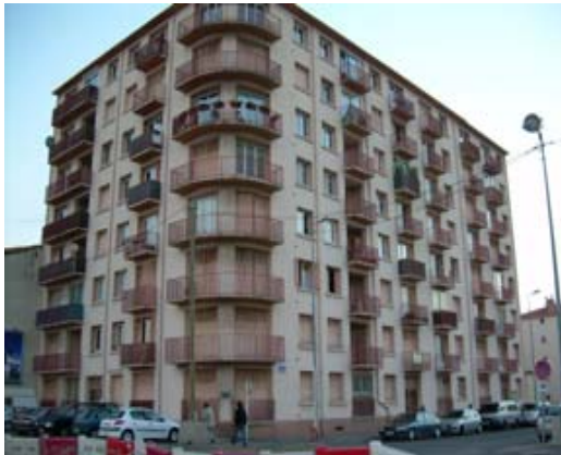
Immeuble « Le Fresnel »
