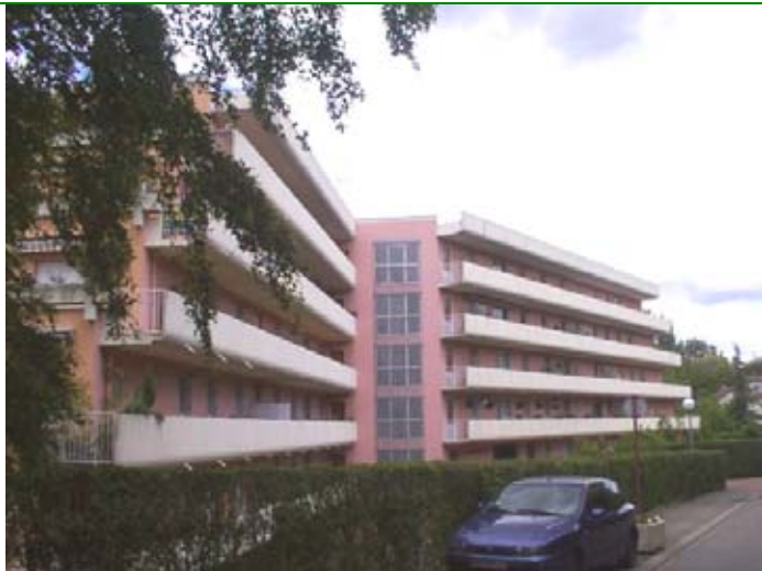
Résidence Grimpré bâtiment 1
