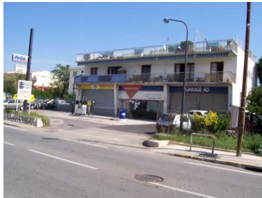
maison individuelle (étage sur station essence)
